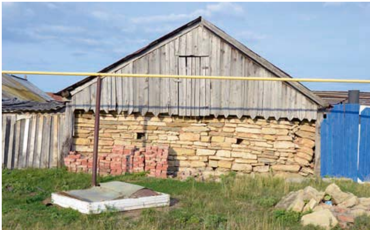
Хозяйственная постройка, сложенная из камня. Село Кубассы, 2019
