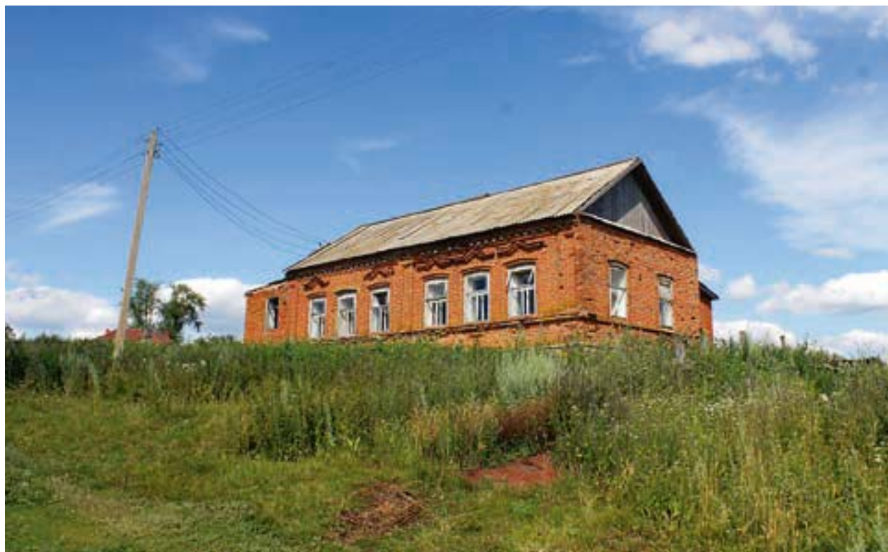
Старинный кирпичный дом. Село Большой Толкиш, 2019
